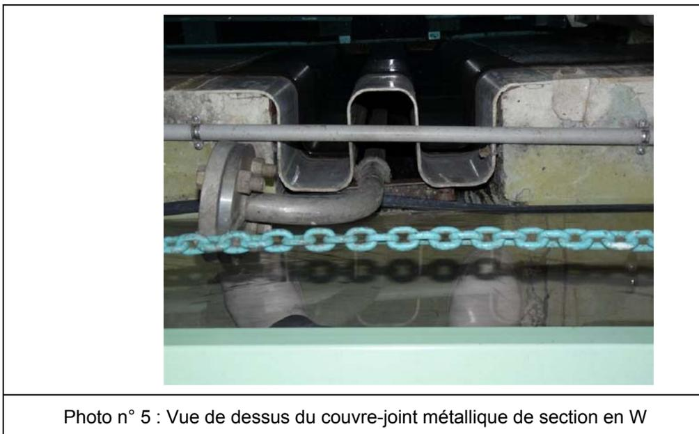
Photo n° 5 : Vue de dessus du couvre-joint métallique de section en W
