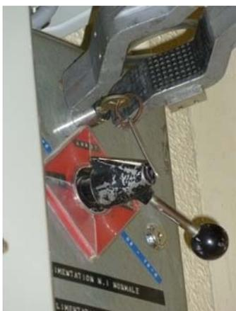
Photo n°11 : Le bras du robot tourne la clé d'alimentation électrique du pont hall pile OSIRIS
