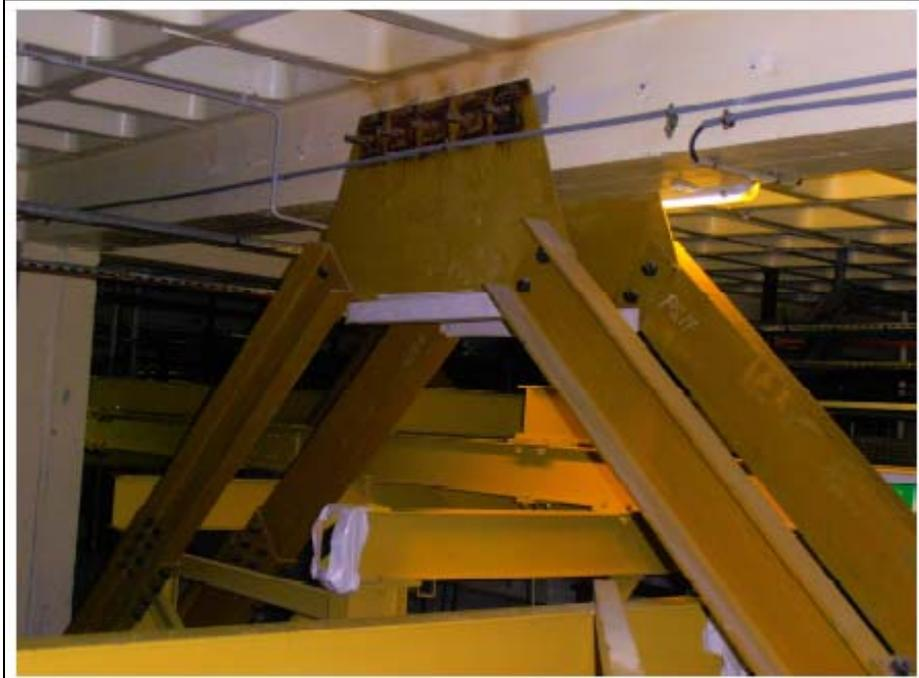
Figure 7 : Eléments de charpentes métalliques de renforcement du dernier niveau du bâtiment principal
