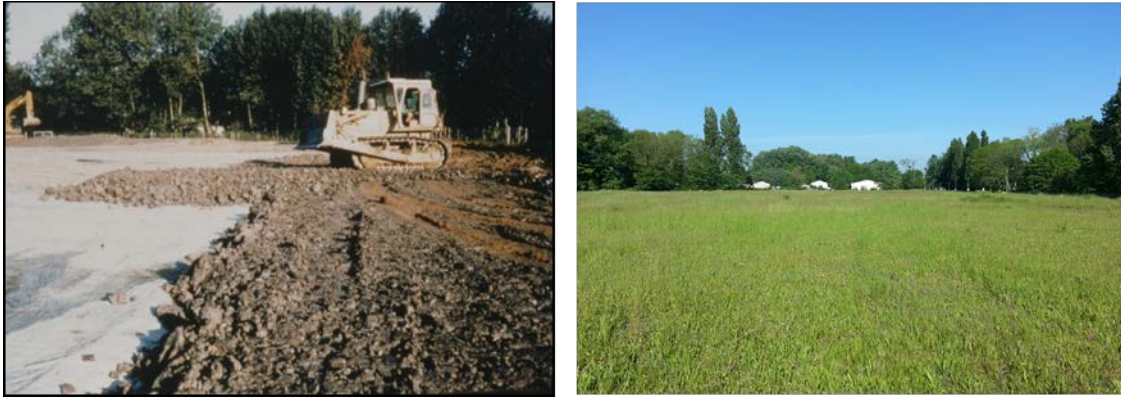
Figure 3 Déposante d'Itteville du CEA (Essonnes) - A gauche : travaux de mise en place de la couverture d'argile, à droite état actuel du site
