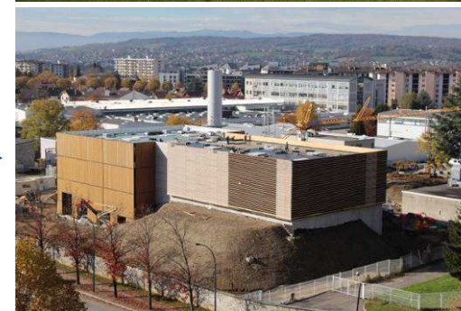
IDEX Chaufferie biomasse
