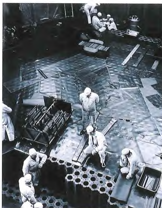
Empilement de graphite dans un réacteur uranium-graphite-gaz
