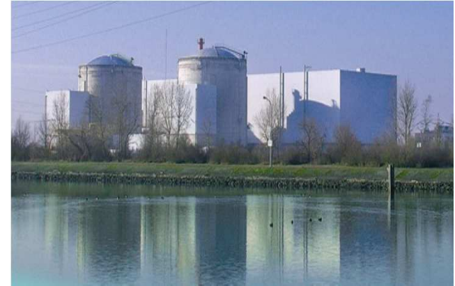
Fessenheim, 2 réacteurs de 900MW 25 inspections en 2014
