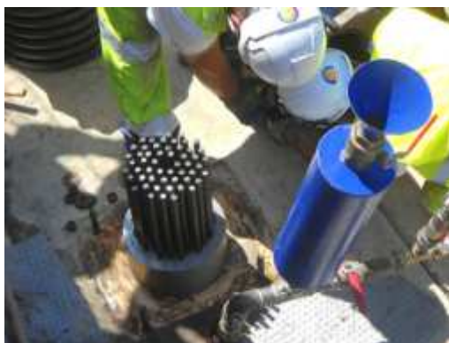
Câbles (151 verticaux, 119 horizontaux) et torons d'un câble de précontrainte
