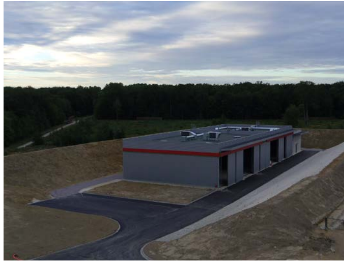
Vue du bâtiment d'entreposage
