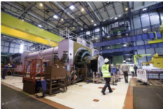
Inspection de chantier à Saint-Alban à l'occasion de l'arrêt du réacteur n° 2, le 20 septembre 2013
