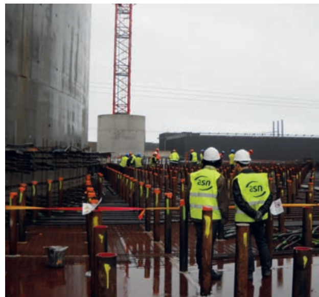
Inspection de l'ASN sur le toit dit « coque avion » en cours de construction du bâtiment des auxiliaires de sauvegarde du réacteur EPR à Flamanville – Janvier 2012
