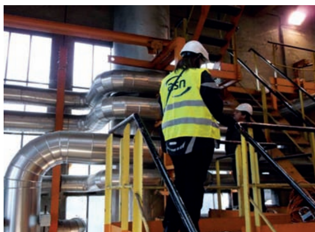
Inspection par l'ASN d'un chantier de radiographie industrielle – Décembre 2012
