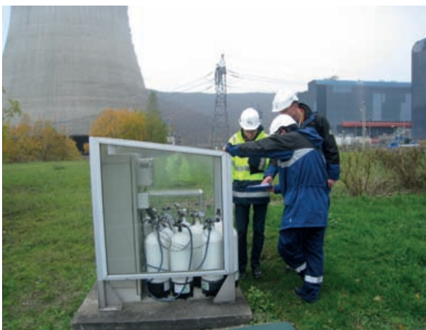
Inspection de l'ASN sur le thème de l'environnement à la centrale nucléaire de Chooz – Décembre 2012
