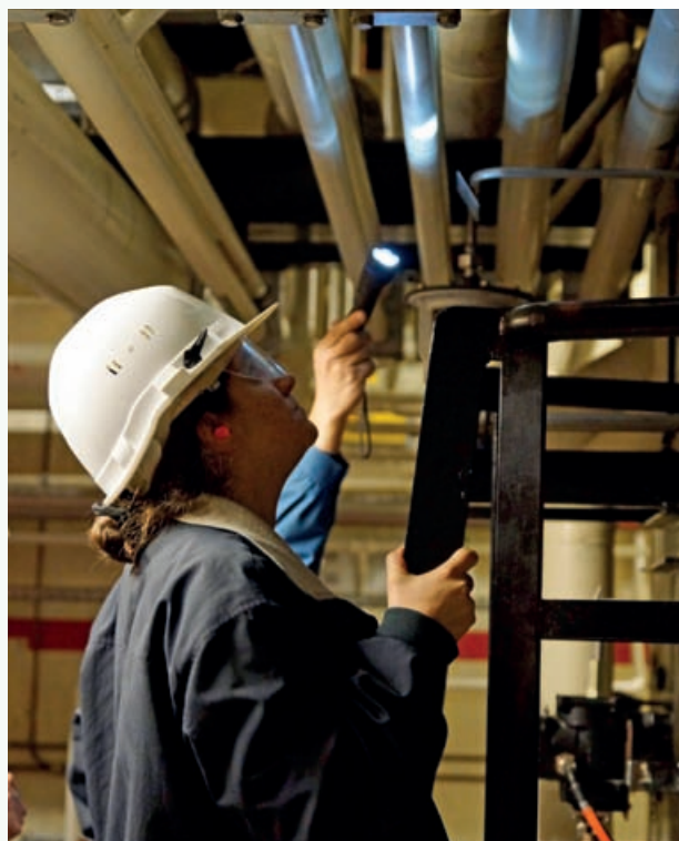
Inspection de l'ASN à la centrale nucléaire de Civaux : contrôle des tuyauteries et des capteurs dans l'un des groupes électrogènes diesels – Octobre 2012
