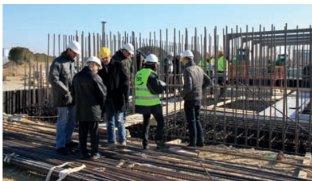
Inspection de l'ASN sur le chantier de l'installation GMMATEC à Marcoule – Février 2012
