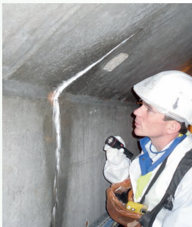
Inspection de l'espace entre enceintes d'un bâtiment réacteur à Cattenom – Décembre 2012
