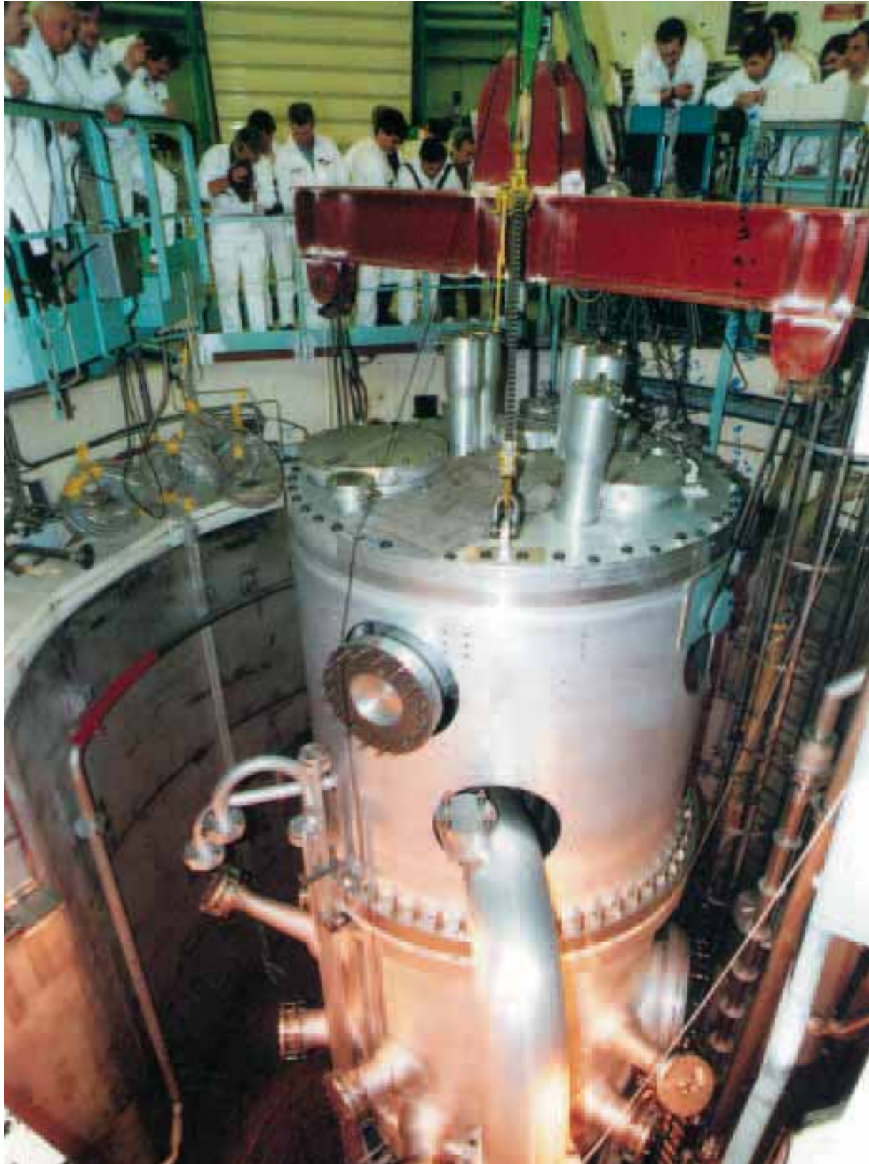
Chargement de la cuve du réacteur à haut flux (RHF).
