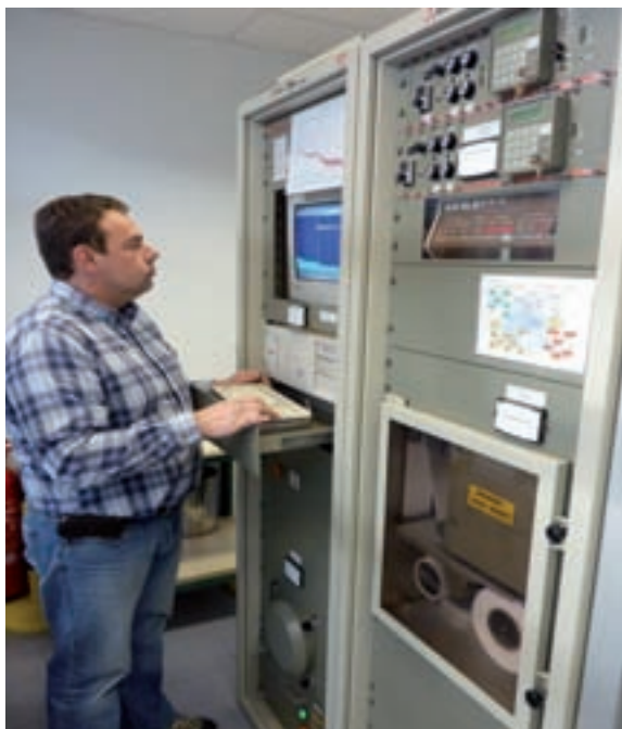
Station de mesure de la radioactivité atmosphérique ASPA Schiltigheim
