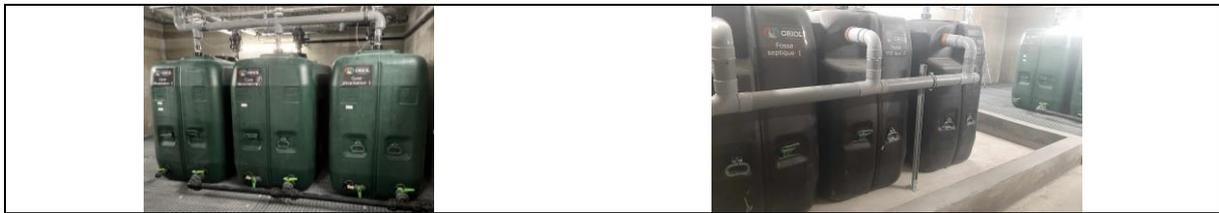
Contrôle annuel du bon fonctionnement des alarmes : Les PCR testent les alarmes de niveau des cuves, et du détecteur de fuite dans le bac de rétention : suivre les instructions et remplir le tableau : **enregistrement qualité** → TD déchets → FOR\_TD\_contr alarme LP/RO/SE
