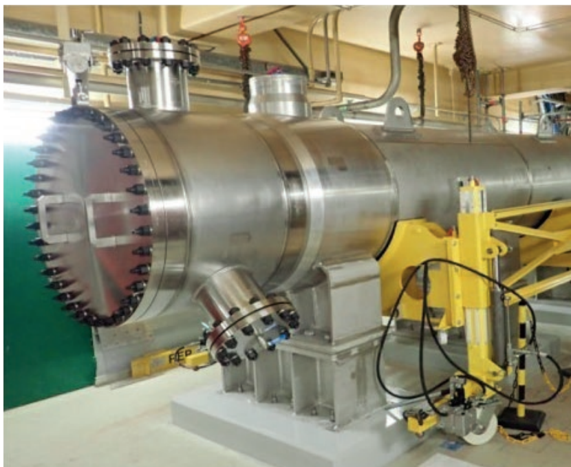
Nouvel échangeur thermique permettant d'évacuer la chaleur en cas d'accident avec fusion du cœur - réacteur 1 de la centrale nucléaire de Paluel (Seine-Maritime).
