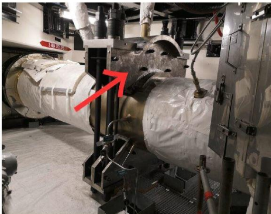
Photo et schéma du collier de maintien sur un piquage « set-in »
