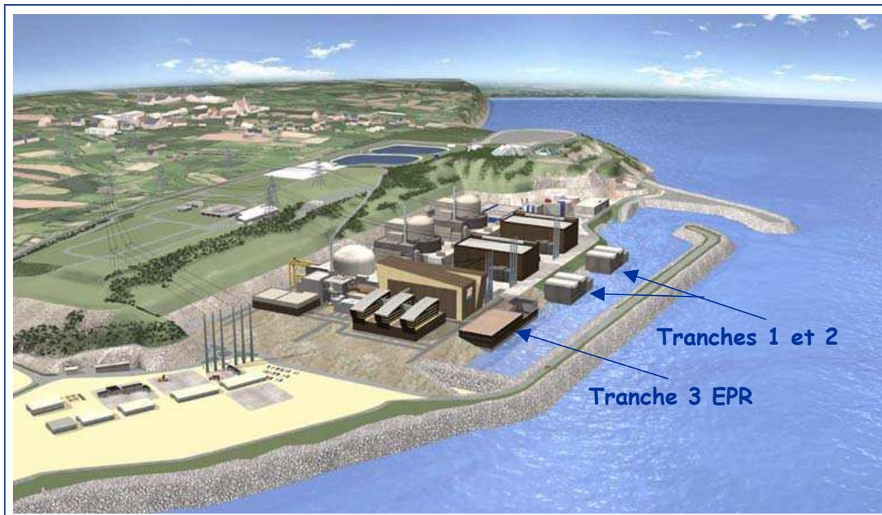
Comme pour les tranches existantes, la réfrigération des condenseurs et des auxiliaires de sauvegarde est effectuée en circuit ouvert par l'eau de mer.
