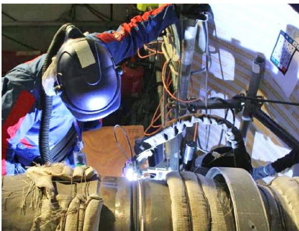
Mise en œuvre du procédé TIG orbital – soudure sur le circuit secondaire principal
