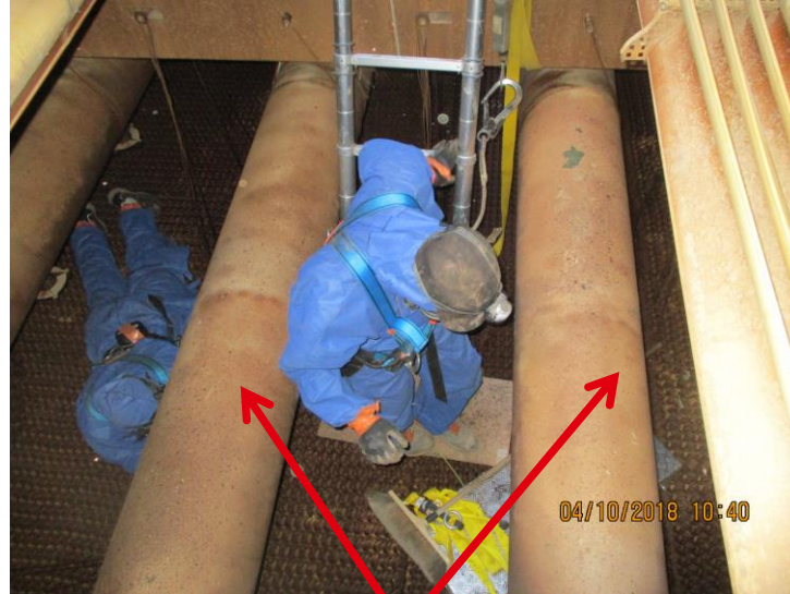
Canalisations amiante-ciment
