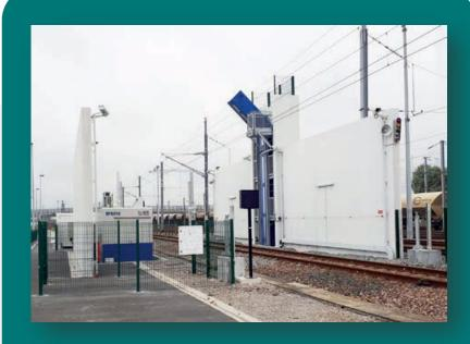
Le premier accélérateur destiné à contrôler des trains de fret en France, installé à l'entrée du tunnel sous la Manche
