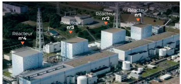
La centrale nucléaire de Fukushima Daiichi était équipée de six réacteurs « à eau bouillante » (REB). Le fluide qui traverse le cœur est de l'eau déminéralisée qui, portée à ébullition au contact des barres de combustible, se transforme en vapeur et actionne des turbo-alternateurs pour produire de l'électricité. Au moment de l'accident, seuls les réacteurs 1, 2 et 3 étaient en fonctionnement (les autres étaient à l'arrêt pour maintenance).
