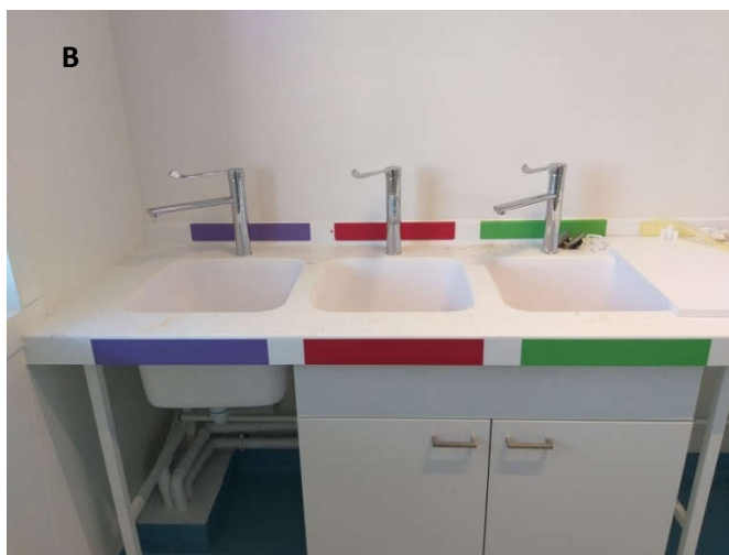
Fig. 10 – Evier actif normal en rouge (A) et évier vers les cuves de curiethérapie, en violet (B)
