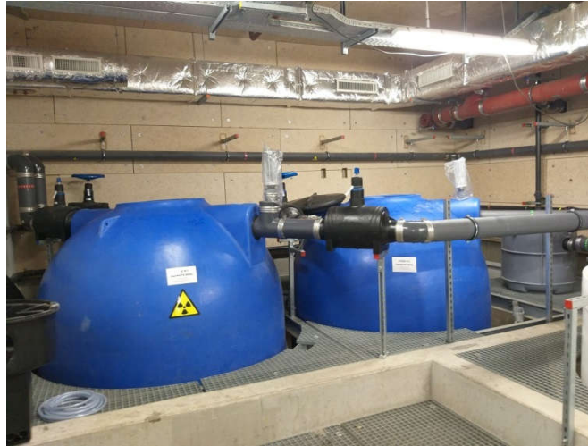
Fig. 12 – Fosses septiques de l'unité de médecine nucléaire
