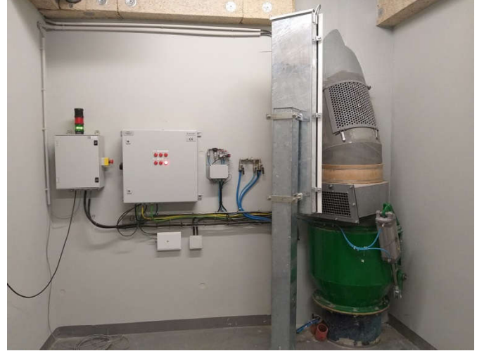
Fig. 7 – Trappe de collecte des déchets DAOM et pied de colonne avec détecteur de radioactivité
