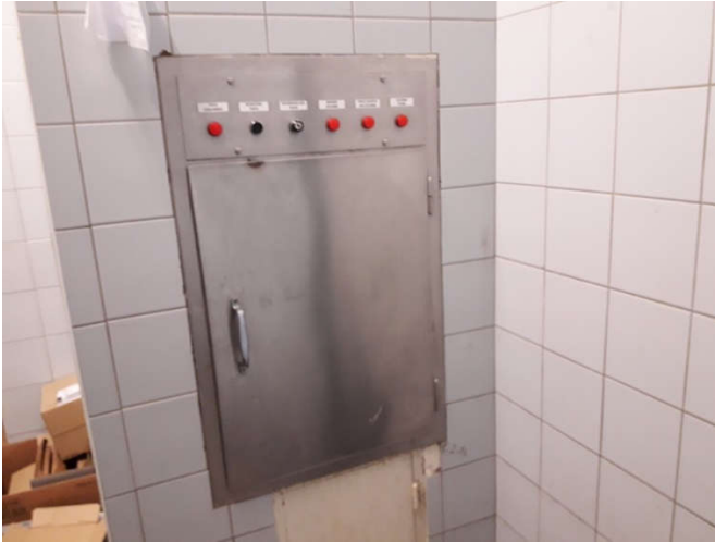
Fig. 7 – Trappe de collecte des déchets DAOM et pied de colonne avec détecteur de radioactivité
