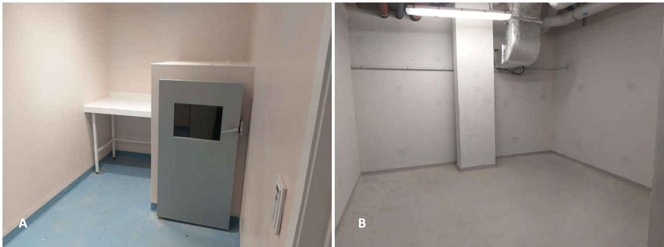
Fig. 4 – Locaux de stockage primaire IR3/02/064 (A) et local de stockage secondaire IR2/00/009 (B)
