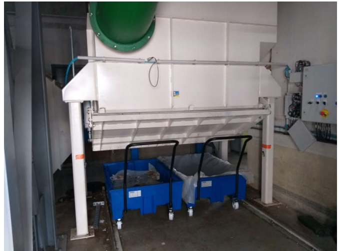
Fig. 8 – Station terminale VIM (à gauche) et trémie de collecte des déchets radioactifs (à droite)
