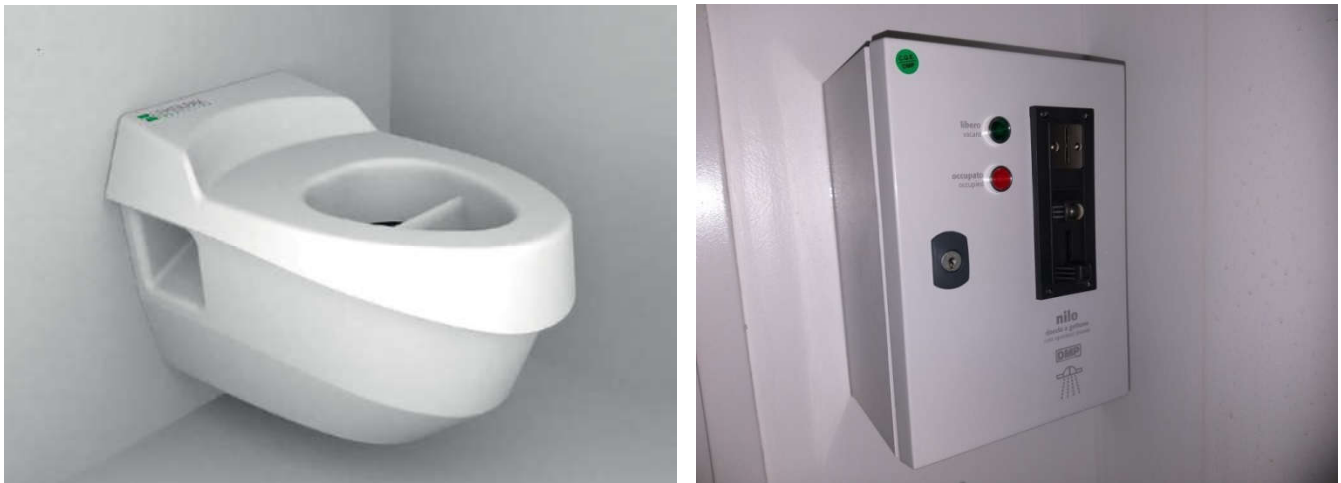
Fig. 2 – Toilettes séparateurs et dispositif de limitation du volume des douches par jetons en curiethérapie.
