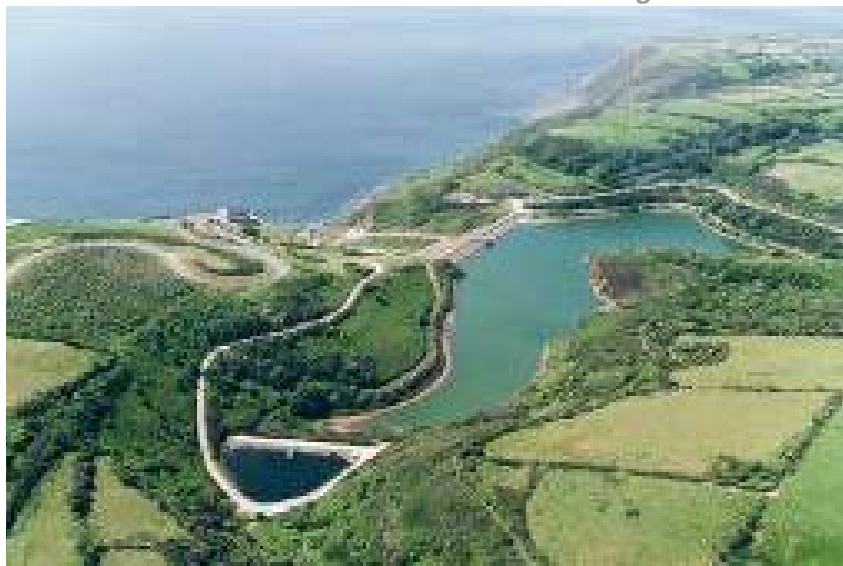
Le barrage des Moulinets
