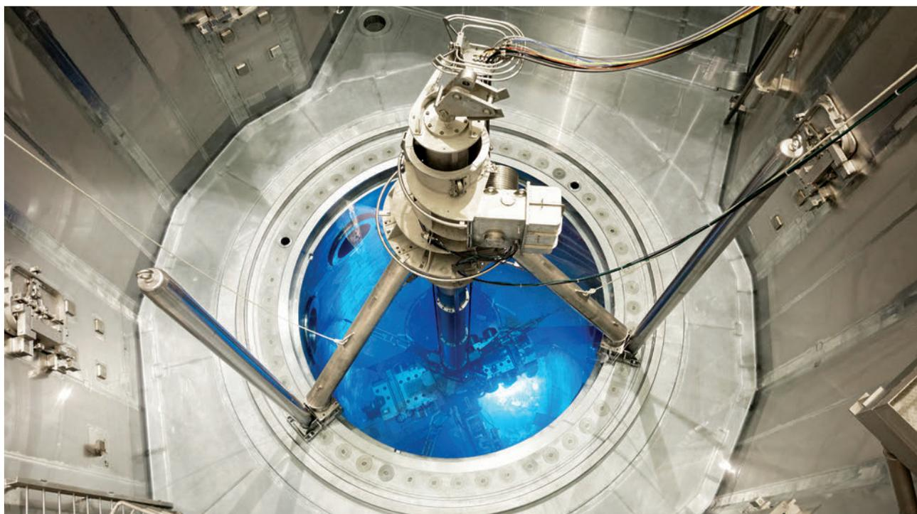
Contrôles de la cuve de l'EPR par la machine d'inspection en service, septembre 2017.
