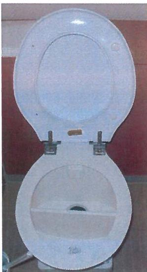
Les sanitaires sont équipés de cuvettes W-C spéciales à séparateur de matières et d'urines (photo CMB3.1). Le siphon principal est celui des matières dures et il est raccordé aux égouts. Le siphon des urines est raccordé à la tuyauterie se dirigeant vers les cuves de stockage et de décroissance.
