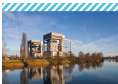
Les deux réacteurs uranium naturel graphite gaz de la centrale de Saint-Laurent des Eaux
