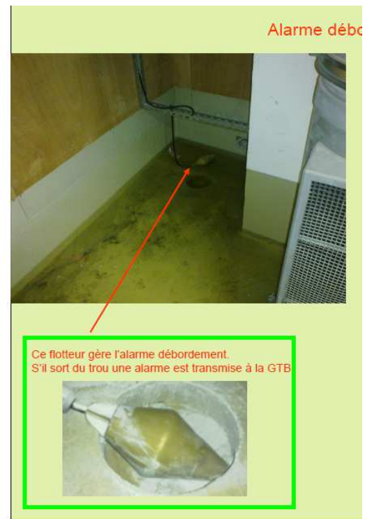
sécurité au niveau du cuvelage
