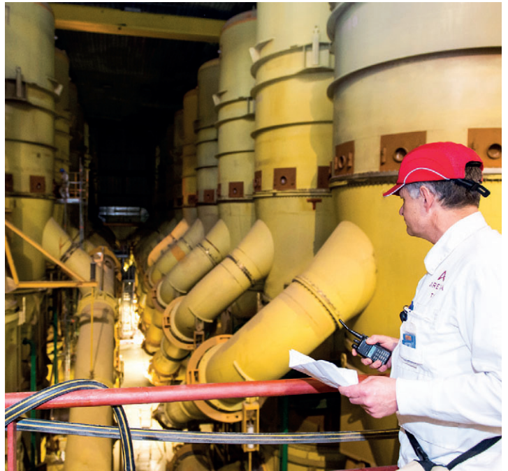
Réalisation des opérations du projet de rinçage intensif - Suivi de la mise à l'air d'Eurodif (Prisme). Chantier du démantèlement de l'usine Eurodif sur le site du Tricastin d'Areva NC.
