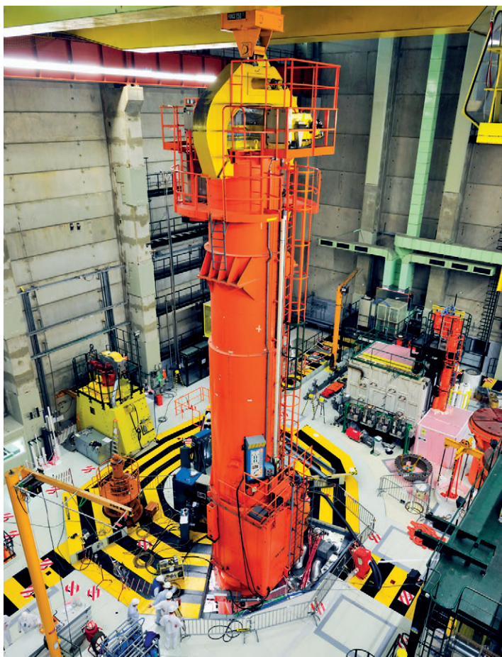
Extraction sous hotte d'un composant primaire sur l'installation Phénix au CEA de Marcoule, avril 2009.
