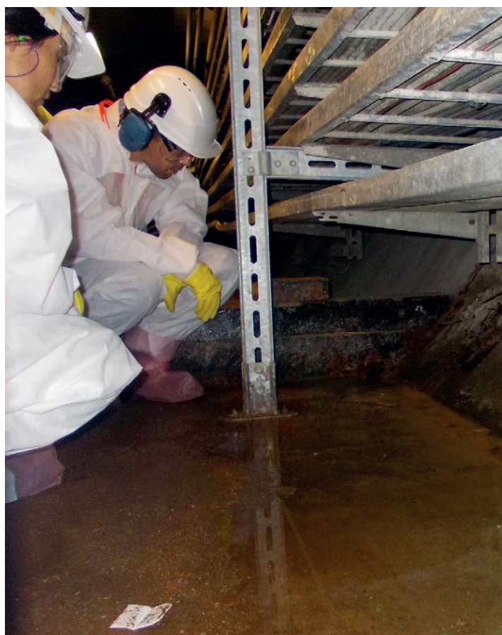
Inspection de l'ASN des galeries techniques à la centrale de Gravelines, juin 2015.
