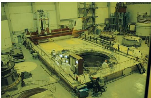
Visite du réacteur Novovoronej-4, en arrêt pour maintenance. Il s'agit du réacteur VVER 440 MWe de 1<sup>re</sup> génération, mis en service en 1972
