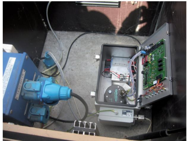
Vue d'un équipement de surveillance sismique (accéléromètre) en place dans une centrale
