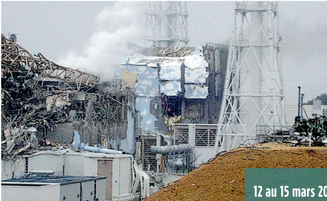
**12 au 15 mars 2011**, le début de fusion du combustible génère de l'hydrogène qui s'accumule dans les bâtiments abritant les réacteurs. Des explosions soufflent les superstructures et font craindre des fissurations des enceintes de confinement des réacteurs.
