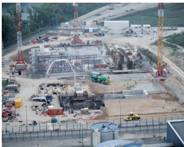
Avancement du chantier de construction de l'installation d'entreposage ICEDA à Bugey – Octobre 2010
