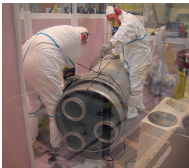
Opération de découpe d'un équipement du réacteur d'expérimentation PHÉBUS à Cadarache
