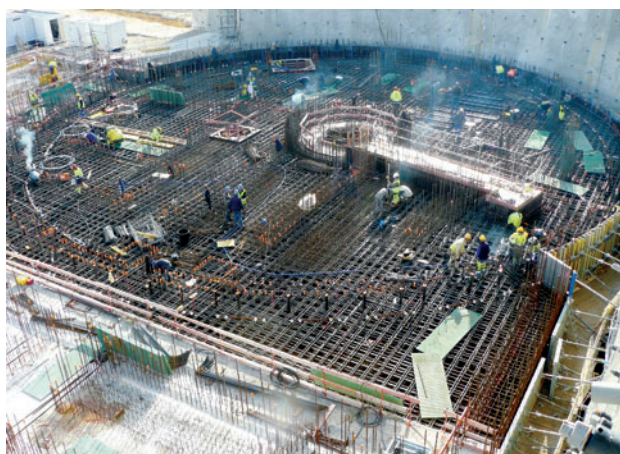
Mise en place du ferrailage du radier supérieur du réacteur Jules Horowitz à Cadarache – Octobre 2010
