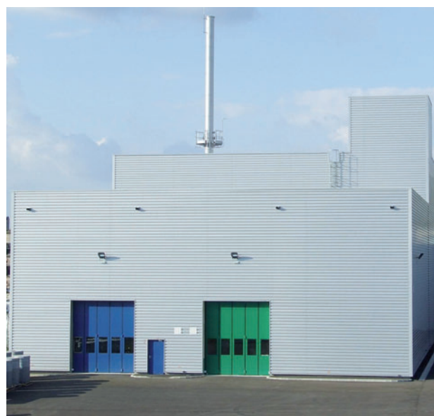
Installation STELLA partiellement mise en service à Saclay – Novembre 2010
