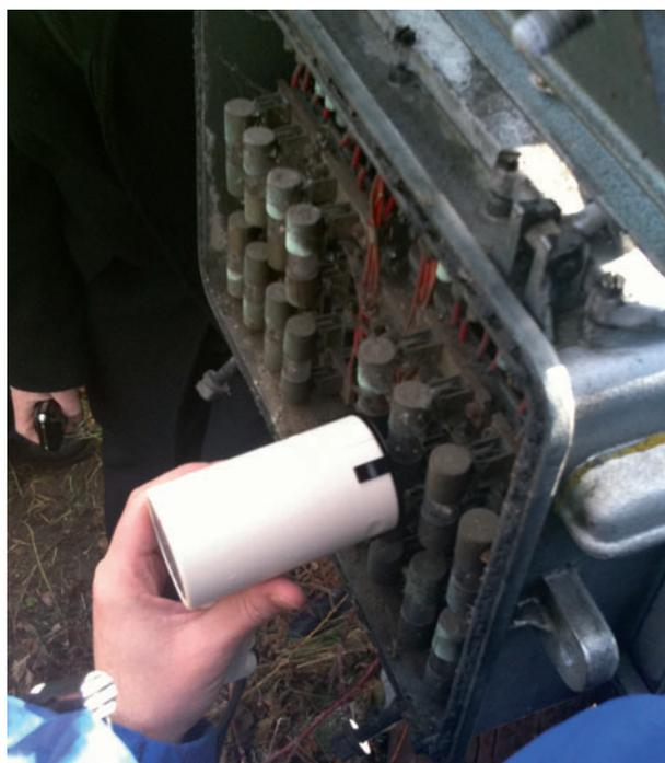
Intérieur du boîtier contenant des parasurtenseurs radioactifs - mesure de la radioactivité en cours
