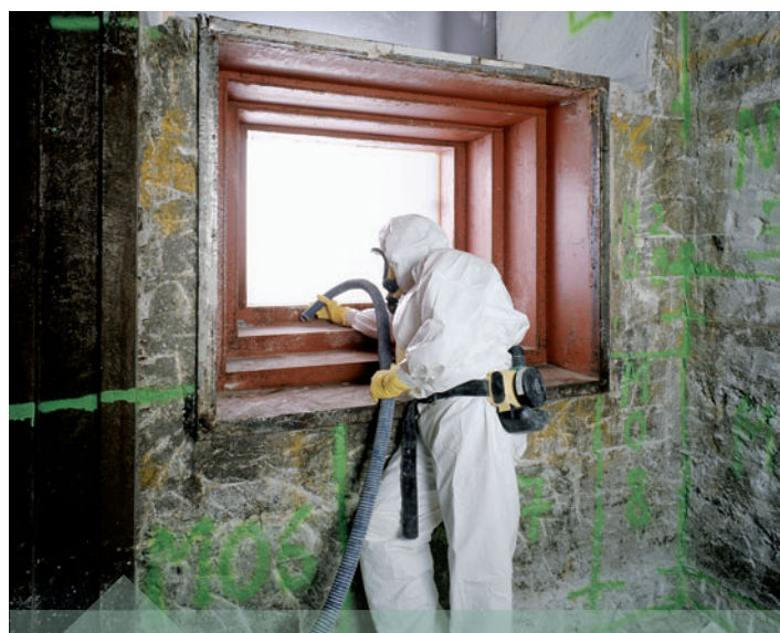
Assainissement de la cellule chaude de l'ancien réacteur de recherche TRITON
