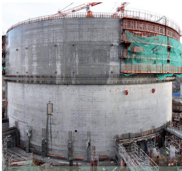
Bâtiment réacteur, chantier de l'EPR à Flamanville — Décembre 2010
