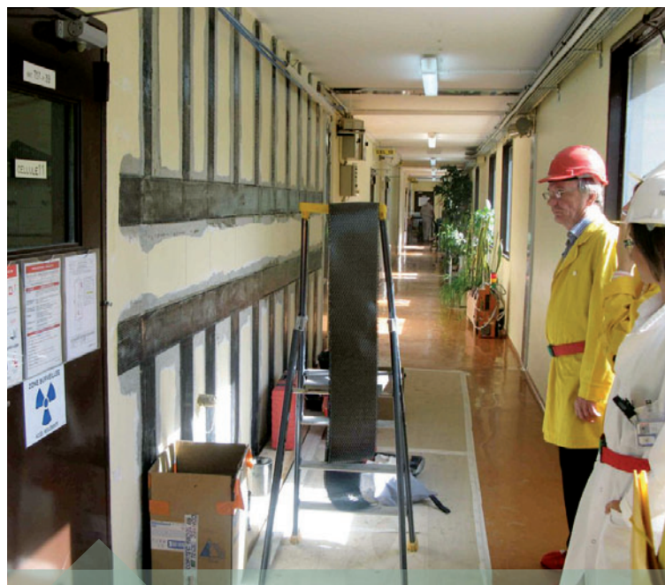
Renforcement parasismique par bandes de tissus en fibres de carbone (TFC) à Cadarache
