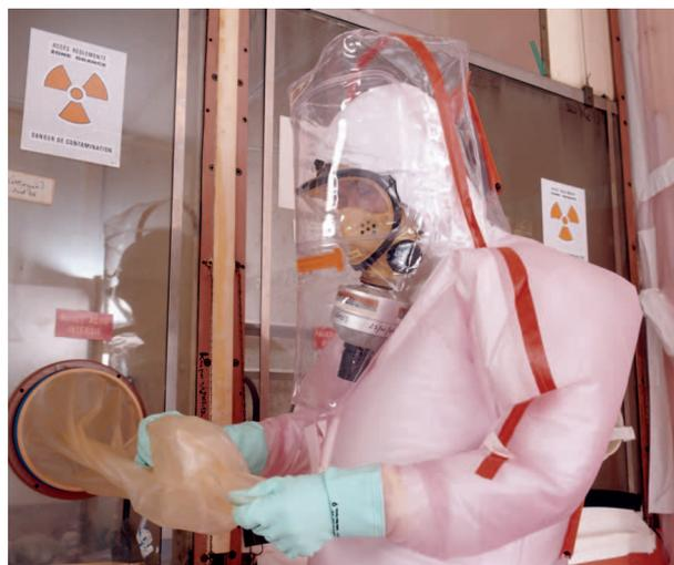
Décontamination du laboratoire de chimie du plutonium de Fontenay-aux-Roses (Hauts-de-Seine) par un opérateur en tenue vinyle ventilée avec protection des voies respiratoires
