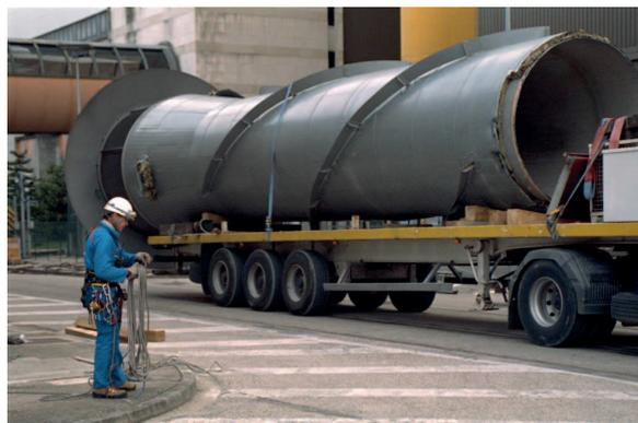
Mise en place sur un semi-remorque d'une cheminée découpée lors des opérations de démantèlement du réacteur SUPERPHÉNIX à Creys-Malville (Isère)
