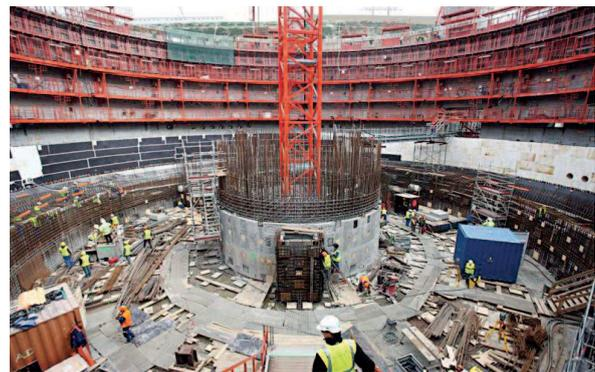
Chantier de construction de l'EPR à Flamanville – mise en place du radier de l'îlot nucléaire – septembre 2009
