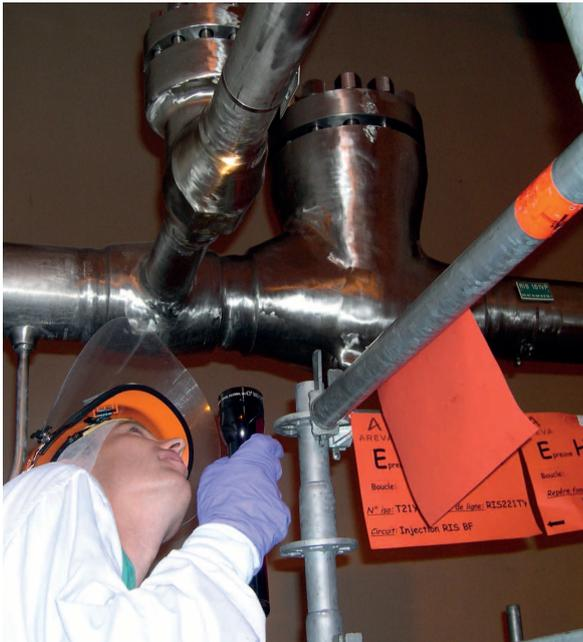
Contrôle des tuyauteries par l'inspecteur de l'ASN lors de l'épreuve hydraulique du circuit primaire à Cattenom (Moselle) – Juin 2008
