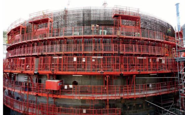
Chantier de construction de l'EPR à Flamanville – septembre 2009 : construction de l'enceinte externe du bâtiment réacteur
