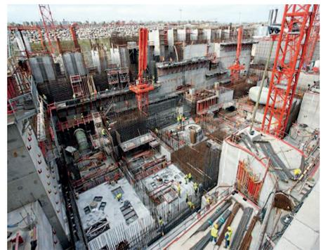
Chantier de construction de l'EPR à Flamanville – septembre 2009 : construction de la station de pompage
