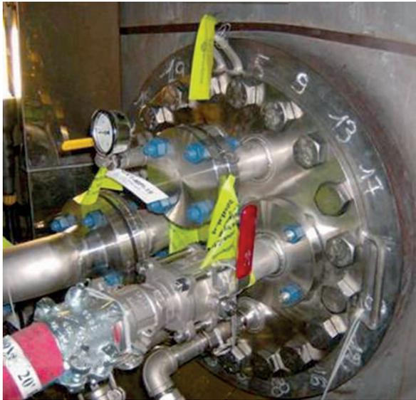
Installation des équipements lors du nettoyage chimique des générateurs de vapeur
