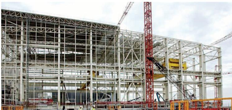
Chantier de construction de l'EPR à Flamanville – septembre 2008 : construction de la salle des machines
