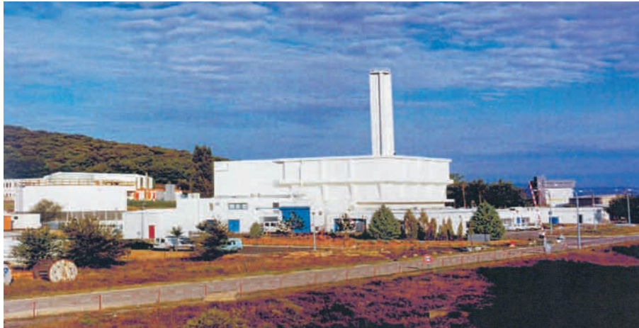
Phébus reactor overview
