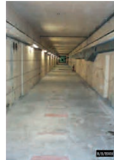
ALS after dismantling
