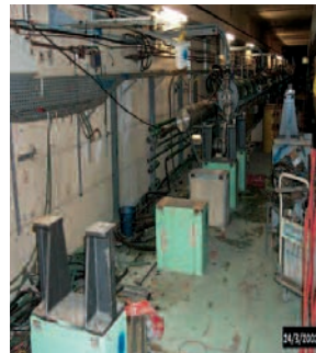
ALS before dismantling
