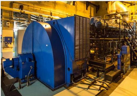
Ces générateurs diesels de secours assurent de façon redondante l'alimentation électrique de certains systèmes de sûreté en cas de défaillance des alimentations électriques externes. En raison de ces défauts, le fonctionnement de ces générateurs diesels de secours en cas de séisme conduisant à une perte des alimentations électriques externes pourrait ne plus être assuré. L'ensemble des défauts constatés a fait l'objet de réparations par EDF.
