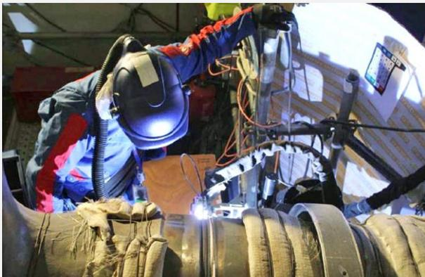
Flamanville ont fait l'objet d'une mobilisation importante d'EDF. En effet, du fait des écarts constatés, une centaine de soudures des circuits secondaires nécessitaient des réparations. EDF a défini des maquettes spécifiques et réalisé des essais pour qualifier les procédés de réparation. L'ASN a exercé une surveillance renforcée de ces chantiers afin de s'assurer de la qualité des nouvelles soudures.
