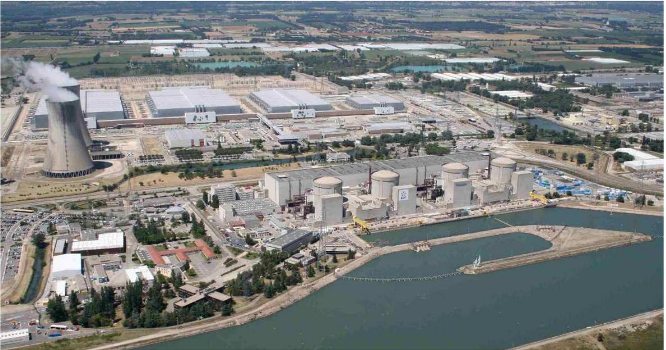
La plate-forme de la centrale nucléaire du Tricastin se situe à la cote 50 m NGF. Une enceinte géotechnique souterraine est ancrée dans les marnes imperméables jusqu'à la cote de 51,40 m NGF. La nappe interne confinée dans cette enceinte est ainsi maintenue en permanence entre les niveaux 46 et 47 m NGF par des pompes de relevage, à une cote inférieure à celle de la nappe phréatique du Rhône.
