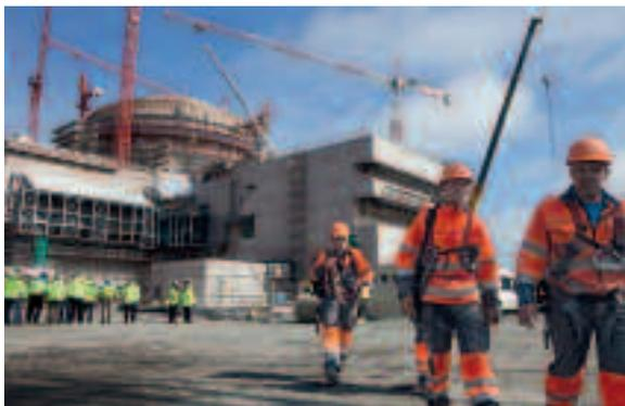
Visite par l'IRSN du chantier de construction d'EPR sur le site d'Olkiluoto, en Finlande. Ouvriers, grues et bâtiment réacteur avec le dôme de l'enceinte de confinement prévu pour résister à un crash aérien
