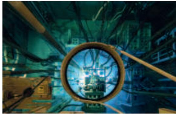
**Vue plongeante de la piscine d'Osiris. Le réacteur de recherche Osiris est implanté sur le centre de Saclay. Il n'est pas destiné à produire de l'électricité mais à accueillir des expérimentations, pour l'étude de matériaux notamment.**
