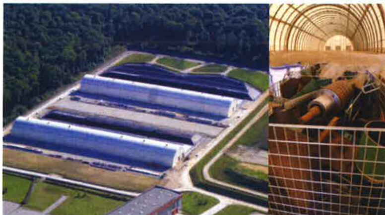
Figure 4 : Centre industriel de regroupement, d'entreposage et de stockage (CIRES)
