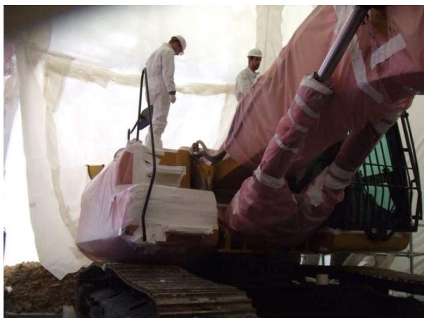
*Figure 7 : Protection d'un engin lors des travaux d'assainissement dans une installation du CEA*
