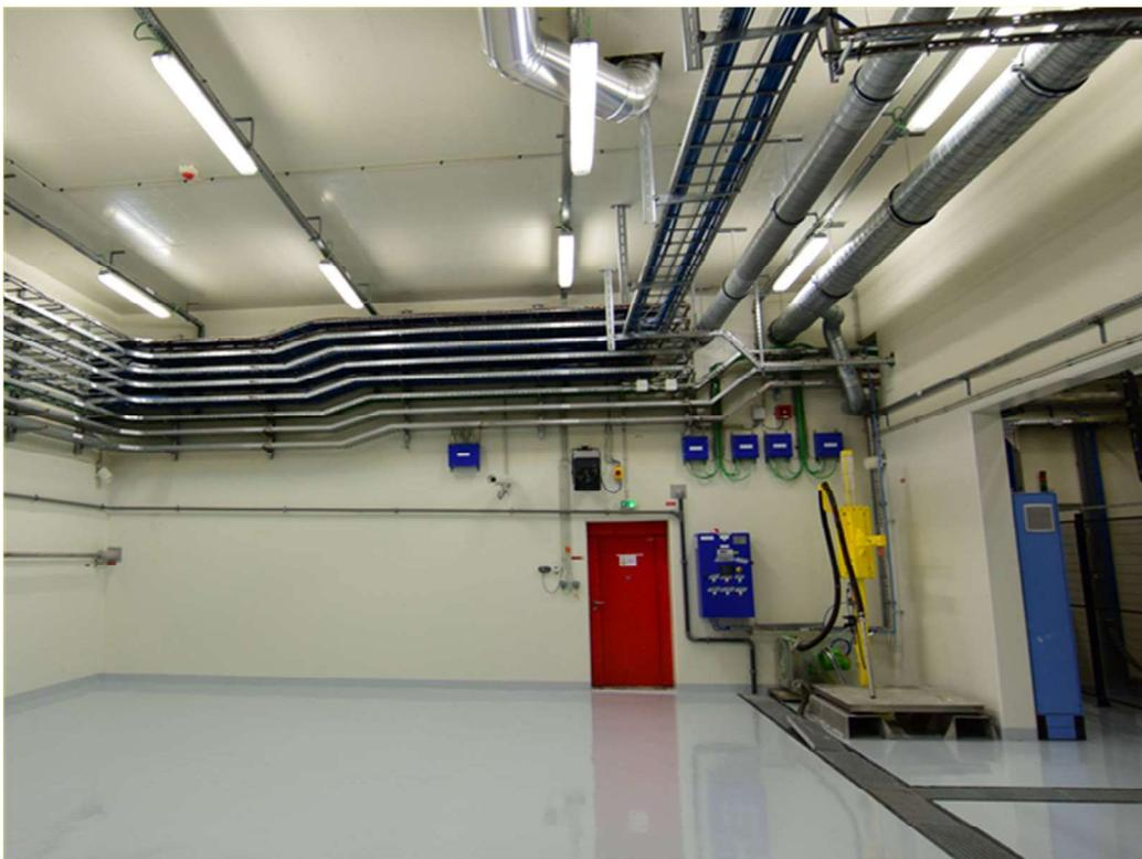
*Figure 10 : Exemple de sol revêtu de résine décontaminable (© EDF ICEDA)*
