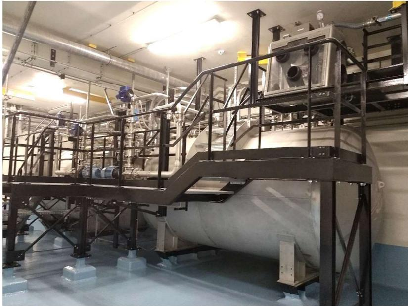
Figure 3 : Exemple de rétention classée ZDC contenant une citerne d'effluents contaminés et une boîte à gants de prélèvement (© EDF ICEDA)
