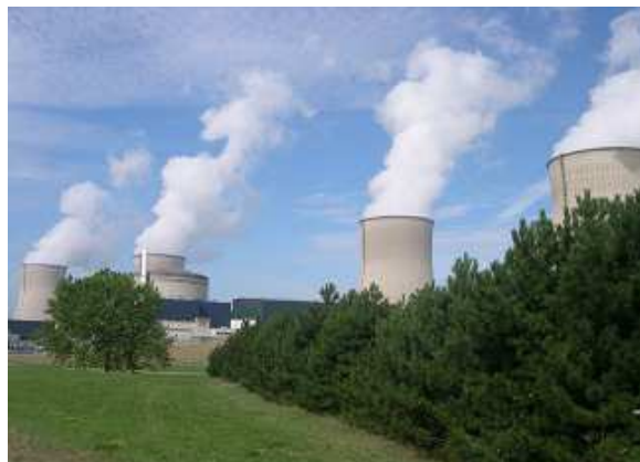
La centrale nucléaire de Cattenom
