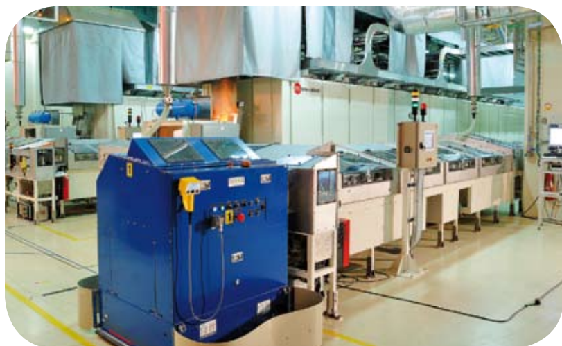
Salle des fours
