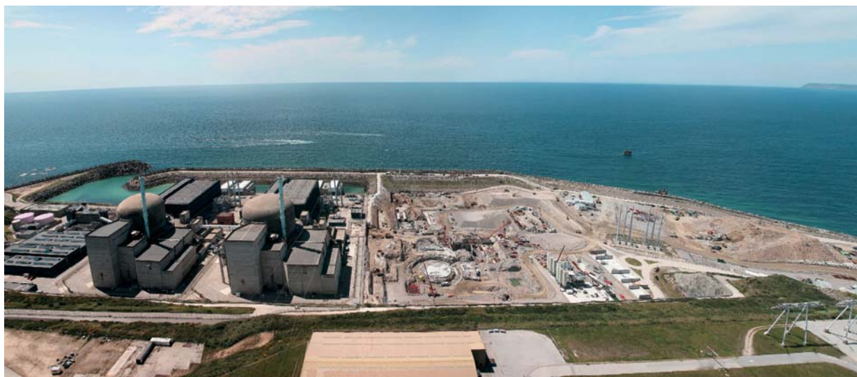
Centrale nucléaire de Flamanville dans la Manche
