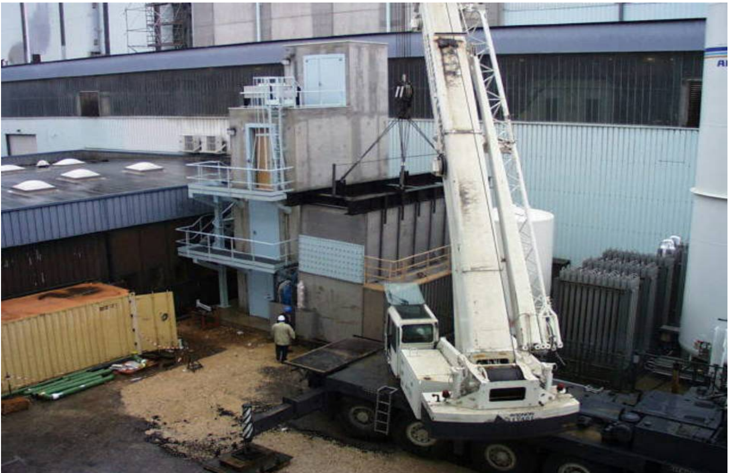
Mise en place des aéroréfrigérants du circuit d'ultime secours
