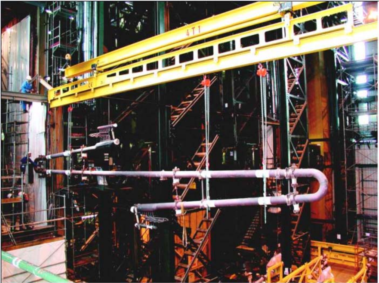
Démontage d'un module d'un générateur de vapeur
