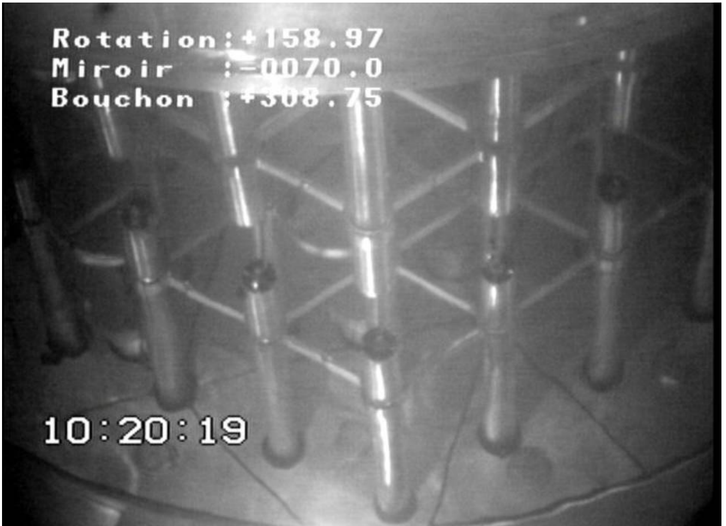
Inspection de la grille inférieure du bouchon couvercle cœur par reflet dans le sodium primaire
