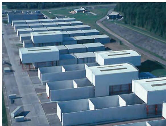
Ouvrages de stockage au centre de l'Aube
