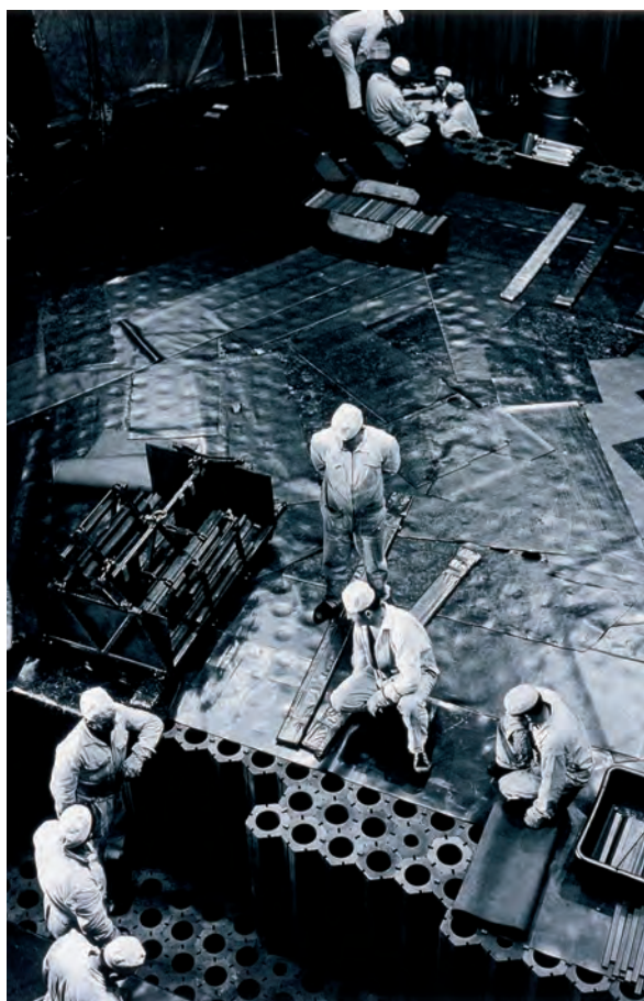
Opérateurs réalisant un assemblage de graphite dans un réacteur
