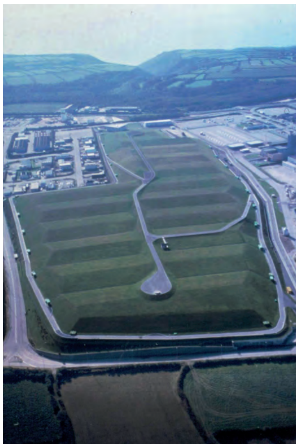
Vue du centre de stockage de la Manche
