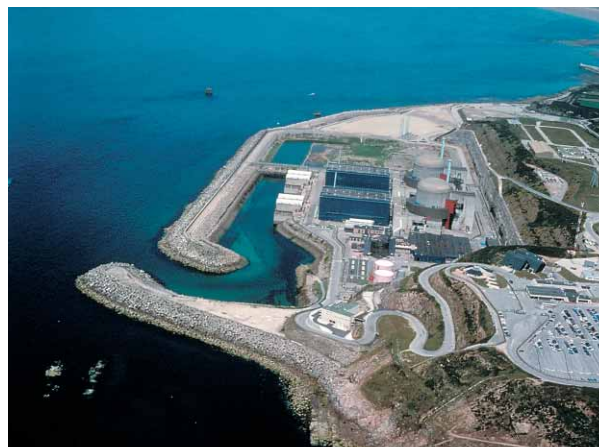
Vue aérienne du site de Flamanville
