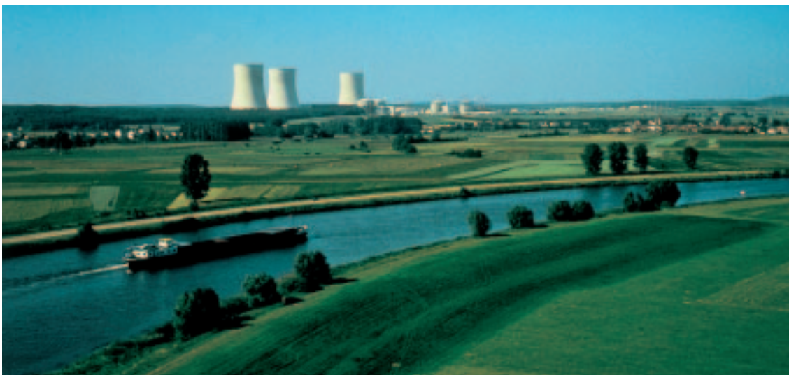
Centrale nucléaire de Cattenom (France)
