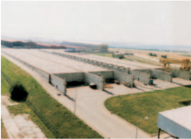
Stockage des déchets de moyenne et faible activité sur le site de la centrale de Dukovany (République Tchèque)
